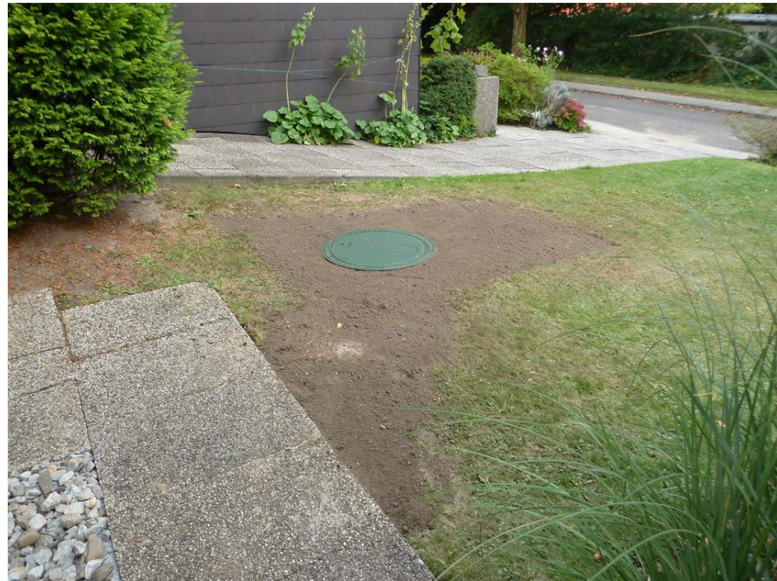
Gartenansicht nach Abschluss des 2-tägigen Einbaus
