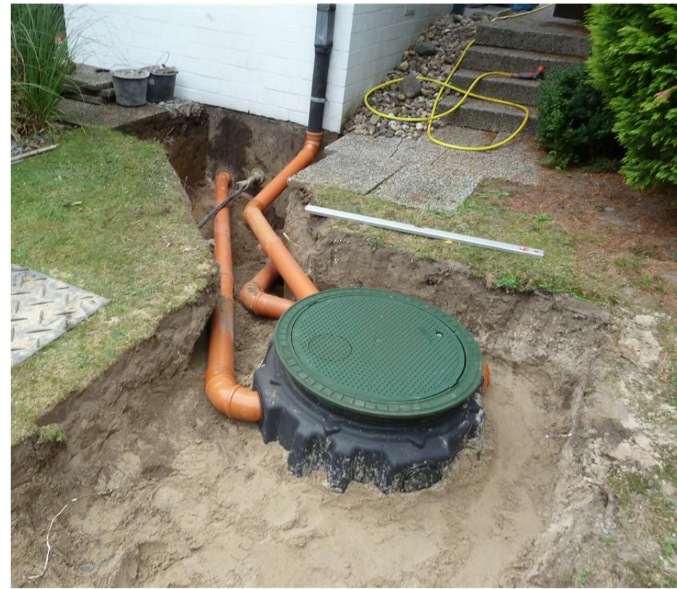
Anschluss an bestehendes Fallrohr, Niederschlagswasserableitung und Brauchwasserzuleitung zum Haus
