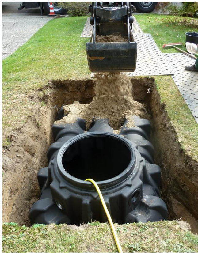
Verfüllung der Randbereiche mit Sand/Kies
