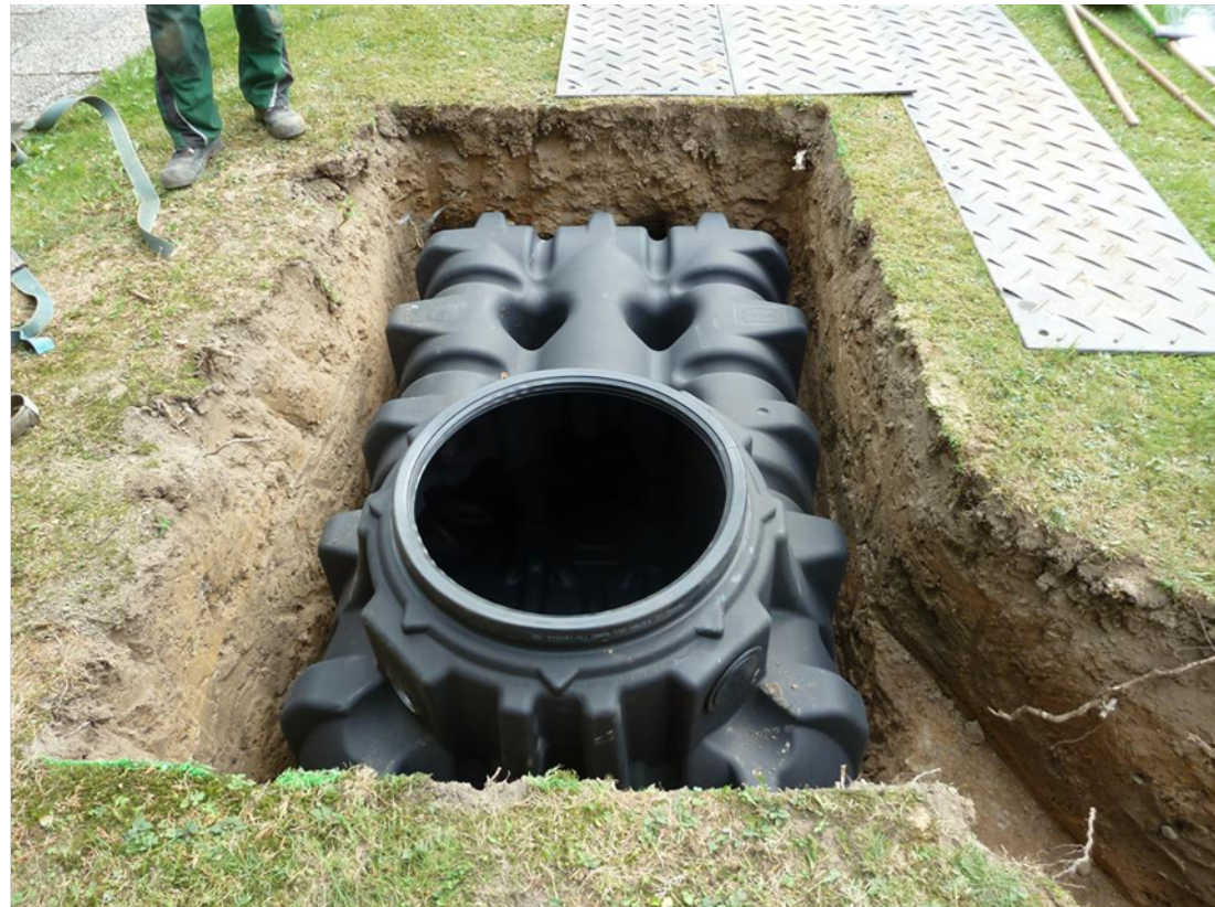
Frostfreier Einbau der Zisterne
